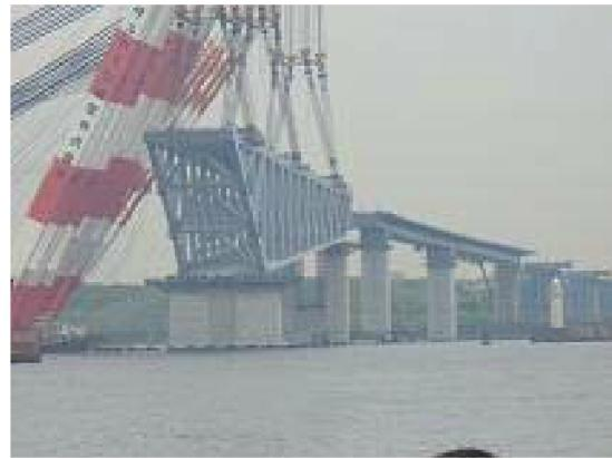
架構工事は、全国でも数隻の、うち最大能力の、武藏7000トン、吉田3700トン、海上4100トン合計14800トン能力のクレーン船を使っての作業であった。
