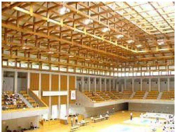
注目すべきは、七つある道は、埼玉県産杉材約2万本を資材として約400立方メートルの集成材を生産、大屋根架構部分に使用している。この集成材を長さ9尺4本、高さ4尺5寸の柱4本部材を単位とし、格子に組み上げながら頂点に向かって積み上げ、登り梁で連結した立体格子架構造である。わかりやすくいえば、4畳半を組み上げ頂点に向かって6段に積み上げたものだ。
