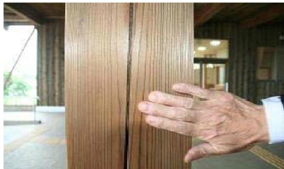
教室と廊下を仕切る壁は秋田杉、体育館の壁がすべて秋田杉無地で赤白込の羽目板を使っており、素晴らしい雰囲気だ。これだけでも大変な予算であったであろう。一階の「下屋のきの張り出し」が二階ではベランダになっており、教室から自由に出入りできるよう設計されている。深い「のき」が張り出し、雨にも当たらず快適な設計だ。最も感動したのは、校舎入口の玄関に、張り出しのきを支える7寸角柱が立ち、校舎に入りする生徒達を睥睨している。もちろん芯持ち柱だ。おりからの入梅による湿気を腹いっぱい吸収し今にもハジケそうだ、木のもっとも素晴らしいところは、入梅時に水分を吸収しジメジメした室内の空気を快適にする。冬はこの水分を吐き出して、乾燥した室内の湿度調整を行う天然の除湿器の機能をはたしているのがはっきりわかった。感激を新たにした次第である。木のよきの標本が正にこの浅内小学校の柱だ。こんな環境で学ぶ生徒も生き生き、先生も生き生き、みな生き生きで視察した我々も生き生きした次第だ。このような世界一の木造小学校を一般ユーザーにも見てもらい、木の良さを分かってもらわねばならない
